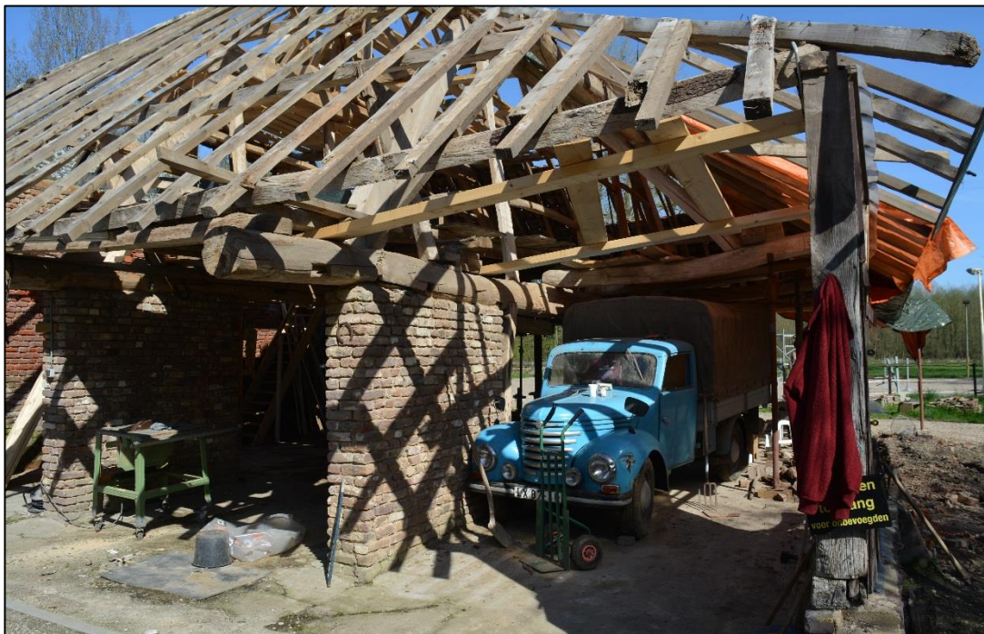
De Rosmolen tijdens de herstelwerkzaamheden aan het dak
