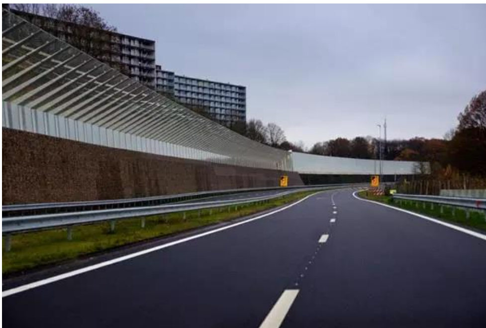
Figuur 3.1: Aanleg Buitenring Parkstad Limburg
